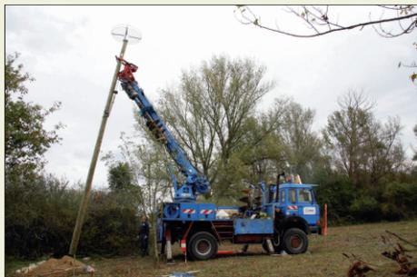
Mise en place d'une plate-forme à cigognes par ERDF Tarn @ A.Calvet
